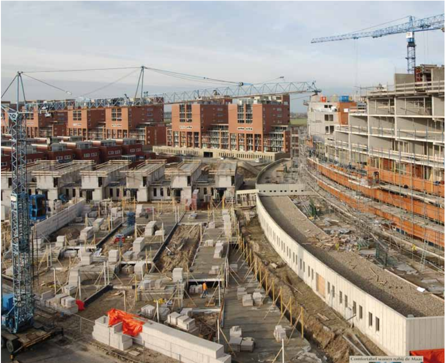
Metropolis in Den Bosch in aanbouw.
