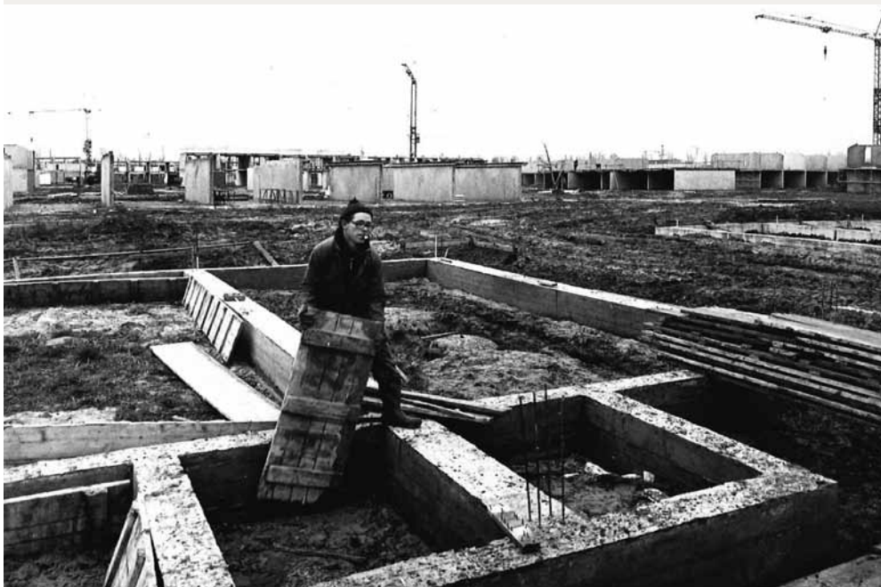
De fundering is gelegd. Het begin van een groot woningbouwcontingent.
