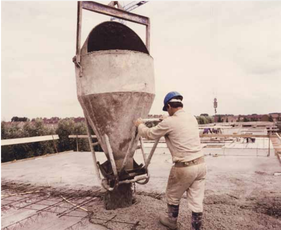
Betonstorten verdiepingsvloer.
