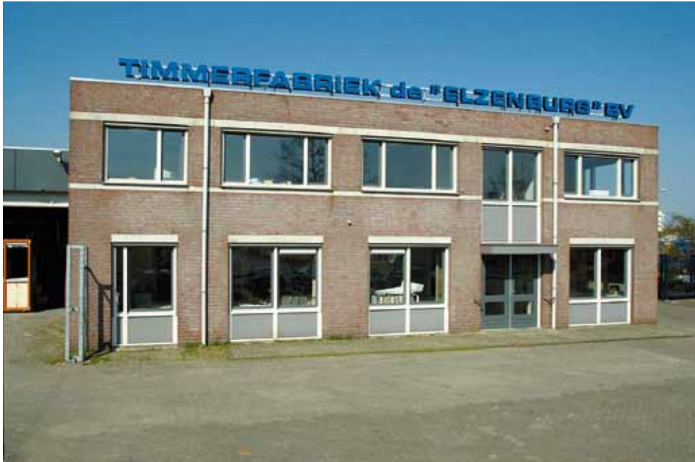
Timmerfabriek de 'Elzenburg'.
