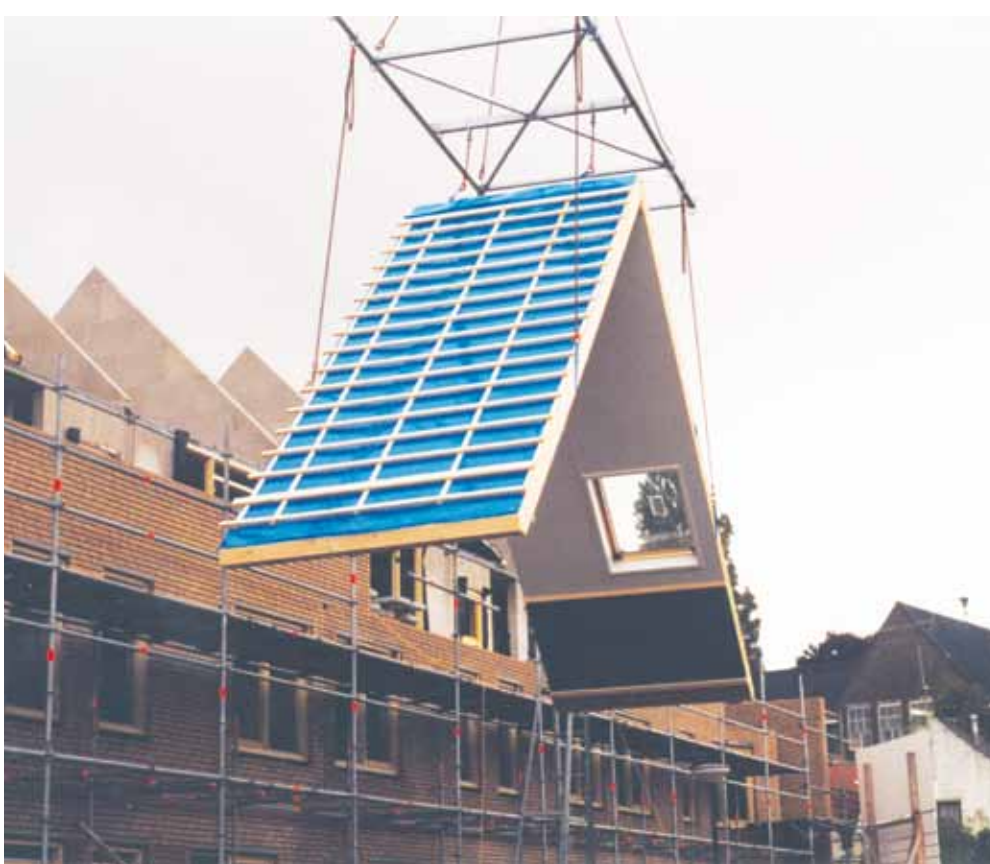
Het plaatsen van een scharnierdak dat als prefabsysteem afkomstig is uit de timmerfabriek in Oss.
